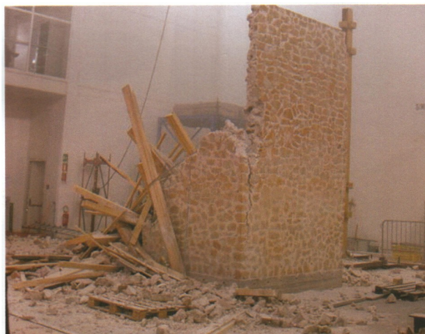
Figura 15: Collasso di edificio in muratura (fonte ENEA)
